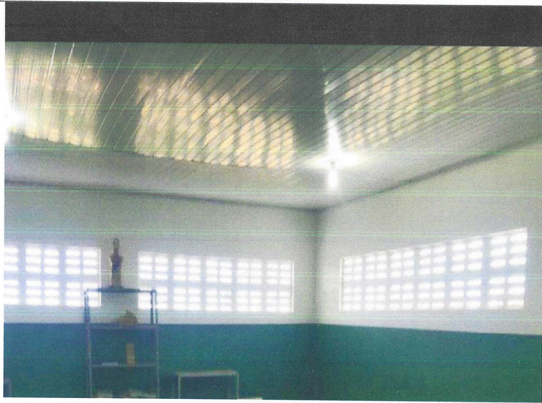
FORRO DE PVC E INSTALAÇÃO DE LÂMPADAS
