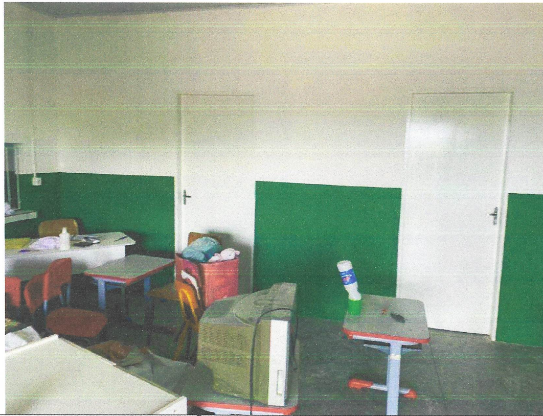
APLICAÇÃO DE TINTA EM ESQUADRIAS
